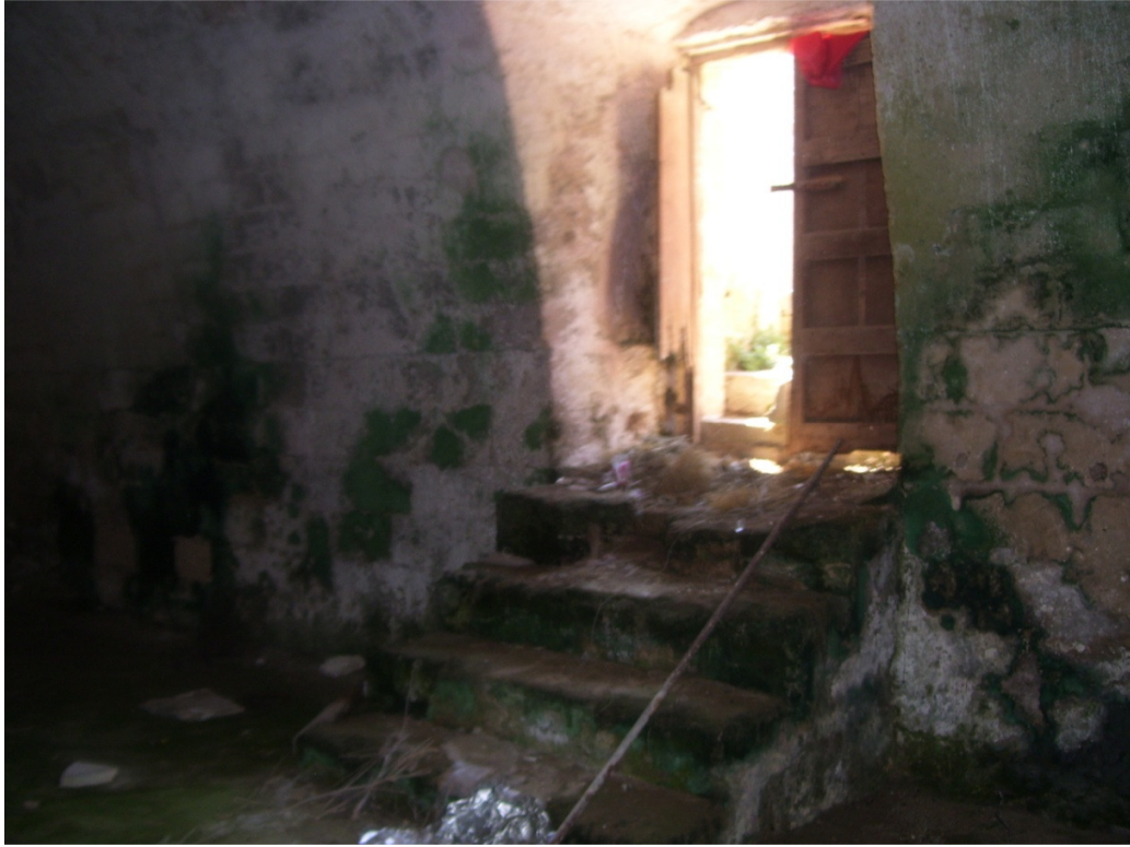
VISTA INTERNA DELL'INGRESSO ALLA CANTINA SEMINTERRATA
