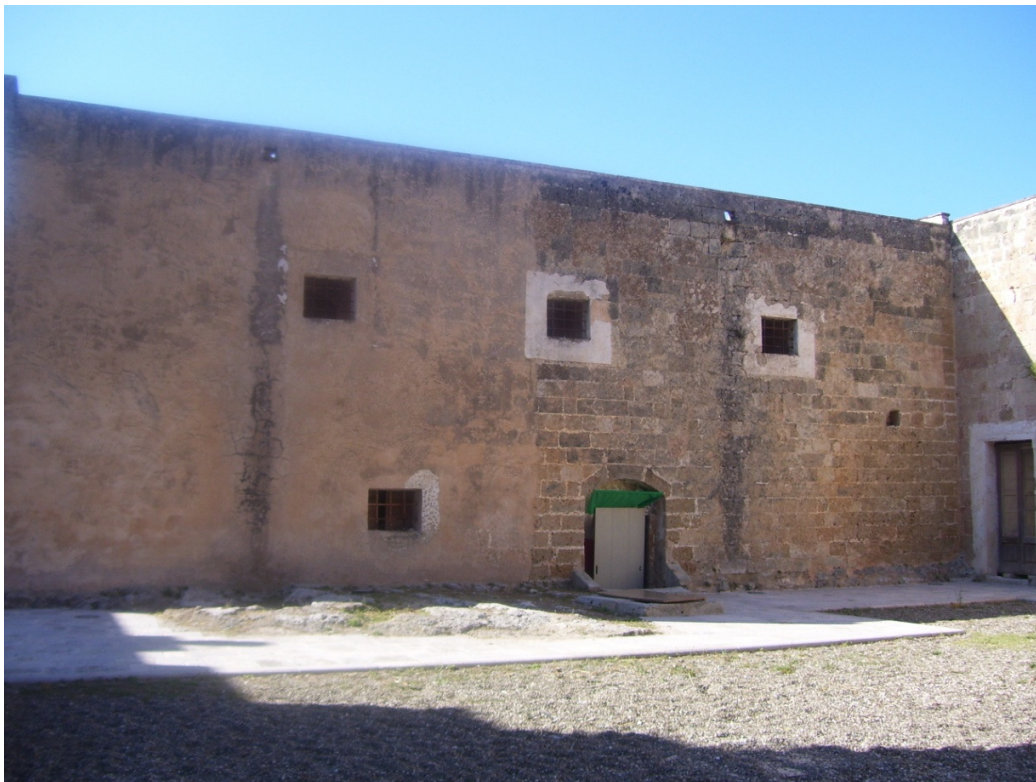
INGRESSO ALLA CANTINA SEMINTERRATA DAL CORTILE INTERNO
