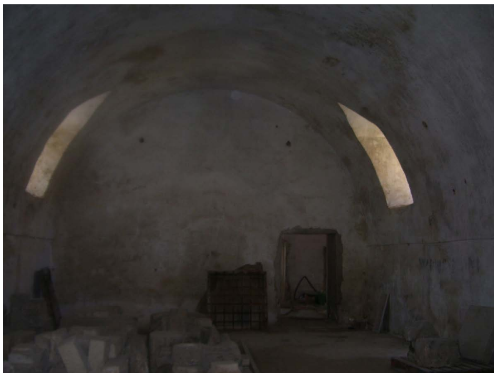
VISTA INTERNA DEL VANO 3
